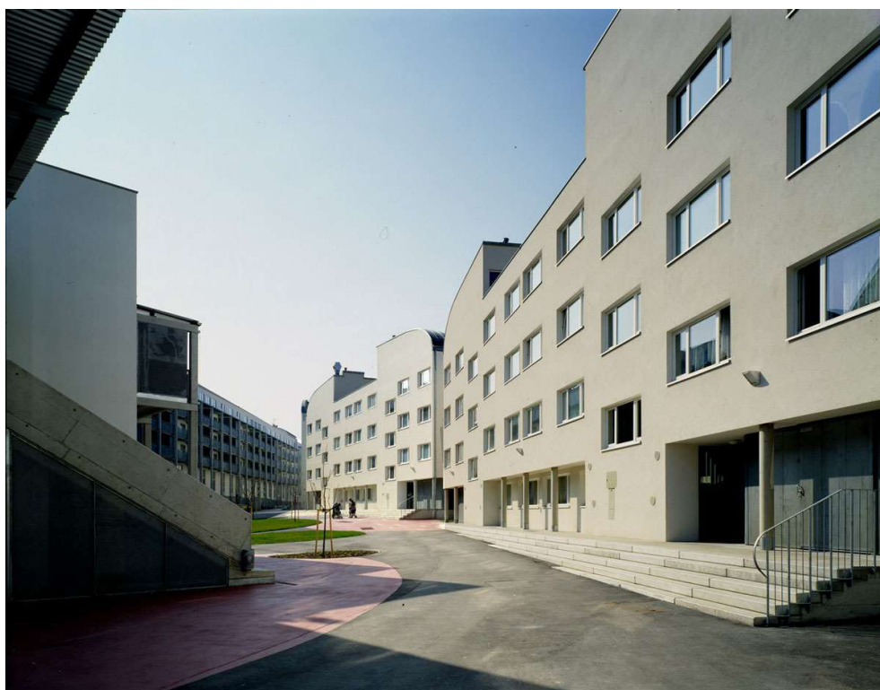
Frauen-Werk-Stadt I, fotografia dell'asse aperto che collega longitudinalmente il complesso. ©Elsa Prochazka
